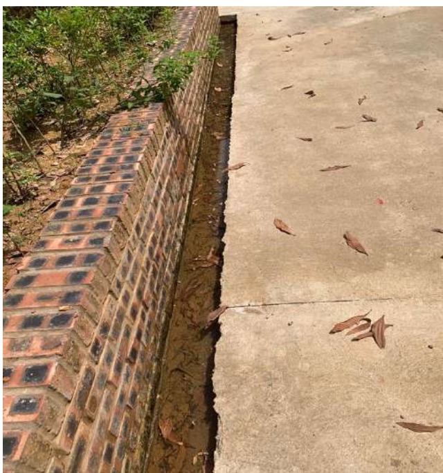
Hình 3.2-Hình ảnh hệ thống thu gom, thoát nước mưa của cơ sở
