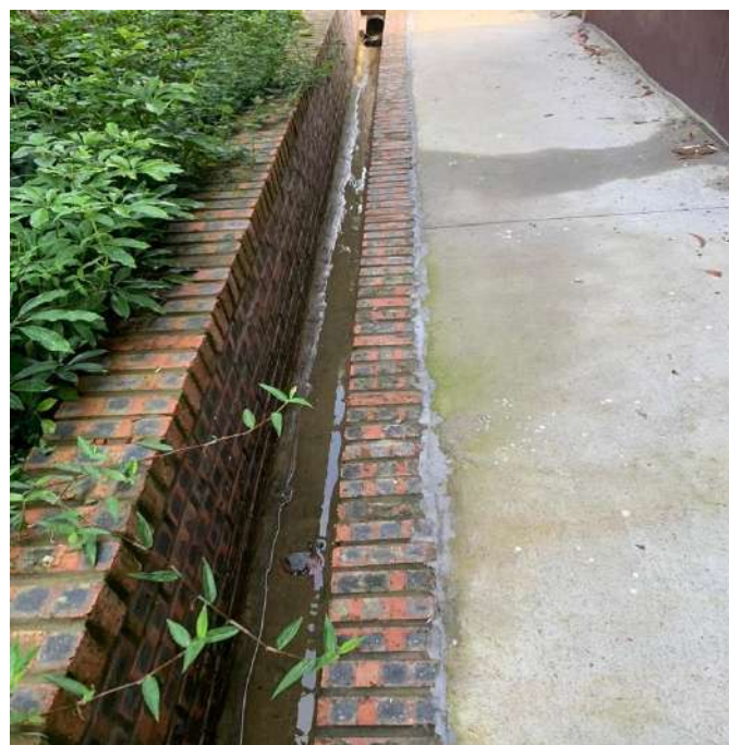
Hình 3.2-Hình ảnh hệ thống thu gom, thoát nước mưa của cơ sở
